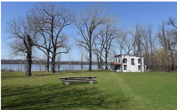
Figure 2: Atelier (en zone inondable)
